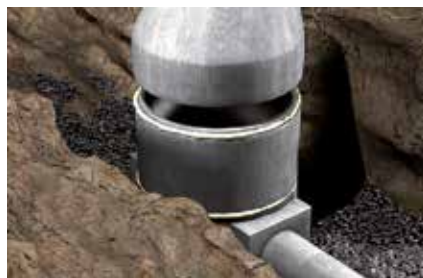
Sigillatura anelli di pozzetti di calcestruzzo
